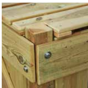
Daken worden geklemd tussen de palen.
